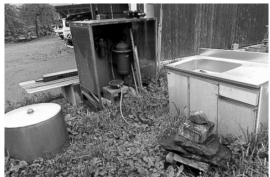
写真5 メタン発酵施設（地下にタンク埋設）
